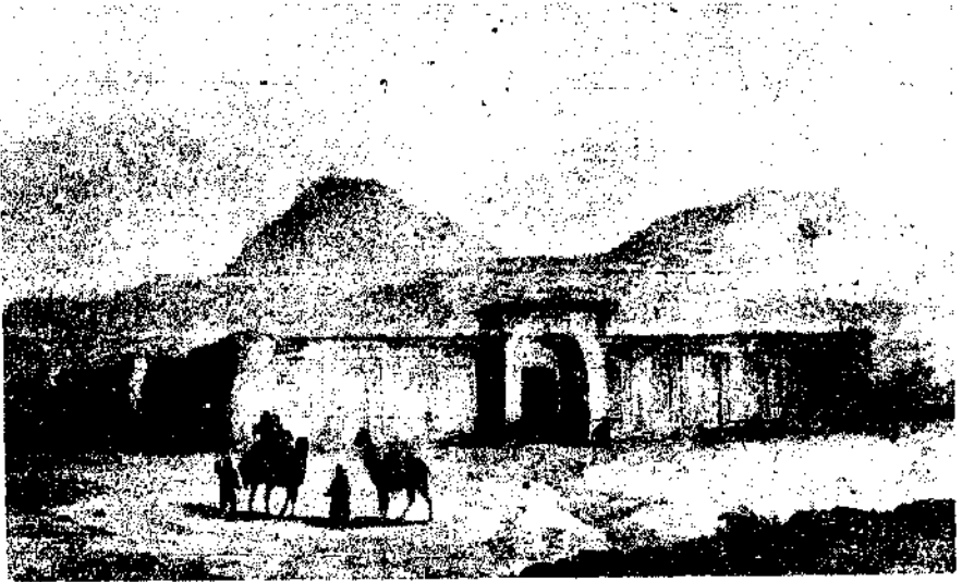
Tebriz civarında bir Kervansaray
