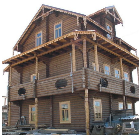
Строительство нового Капища Веды Перуна в Асгарде
